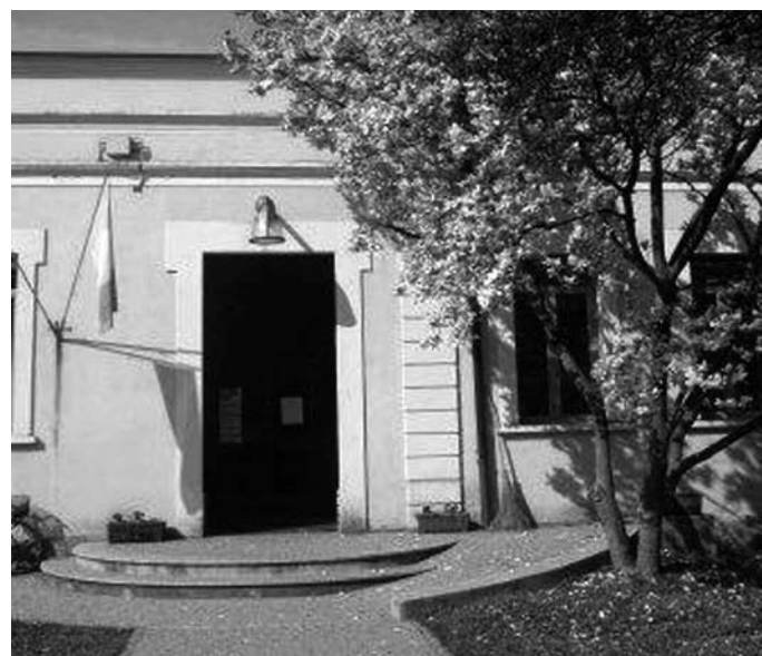
Sabbioni: ampliamento della scuola primaria
