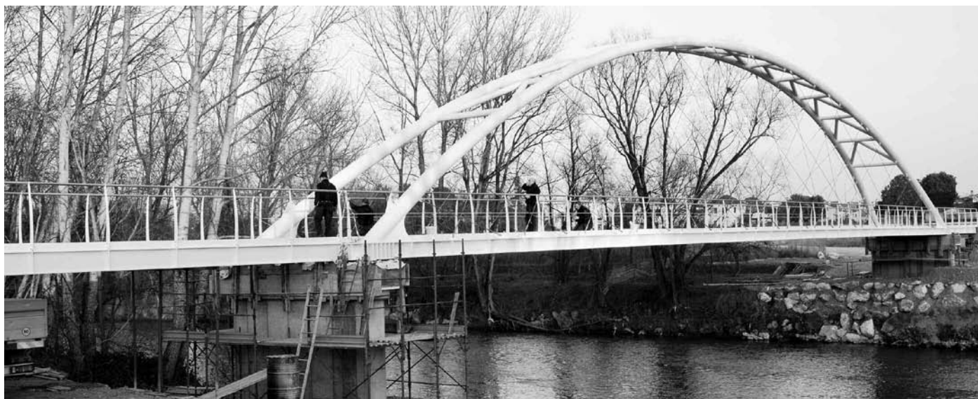
Castelnuovo: passerella ciclopedonale sul fiume Serio per collegare il quartiere al centro città
