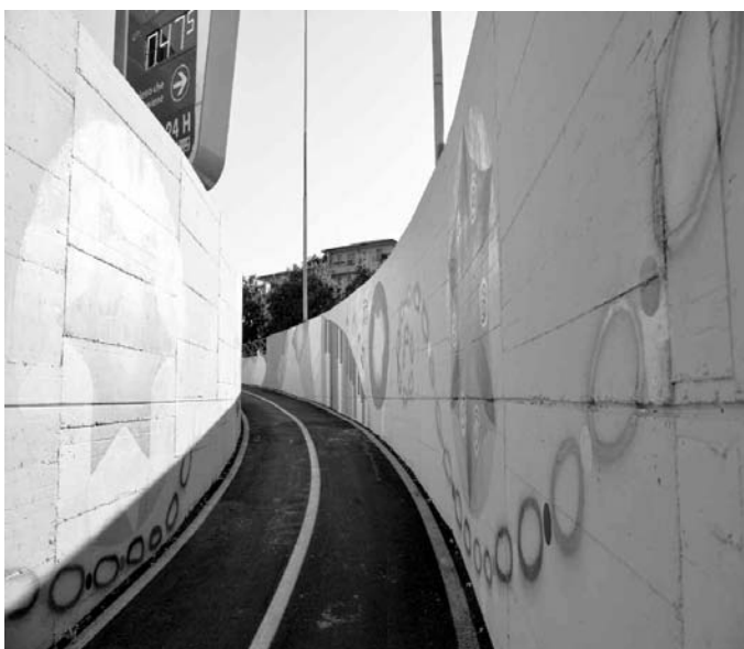
San Carlo: sottopasso ciclopedonale in via Milano
