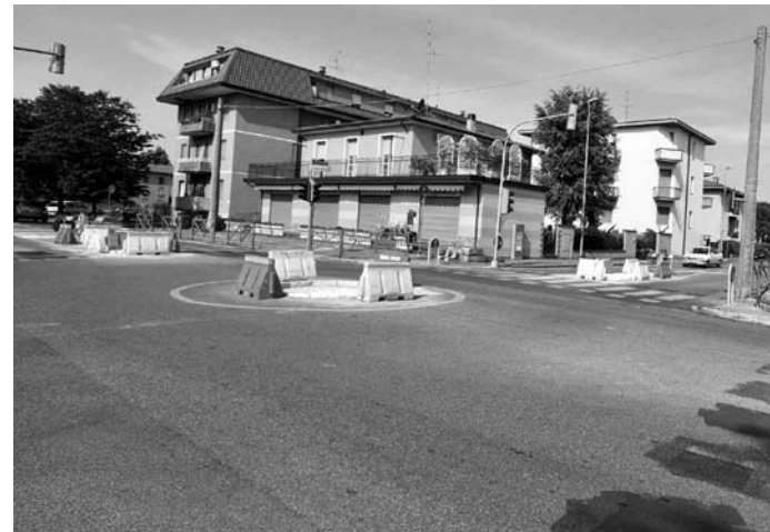
I lavori per la rotonda in via Indipendenza
