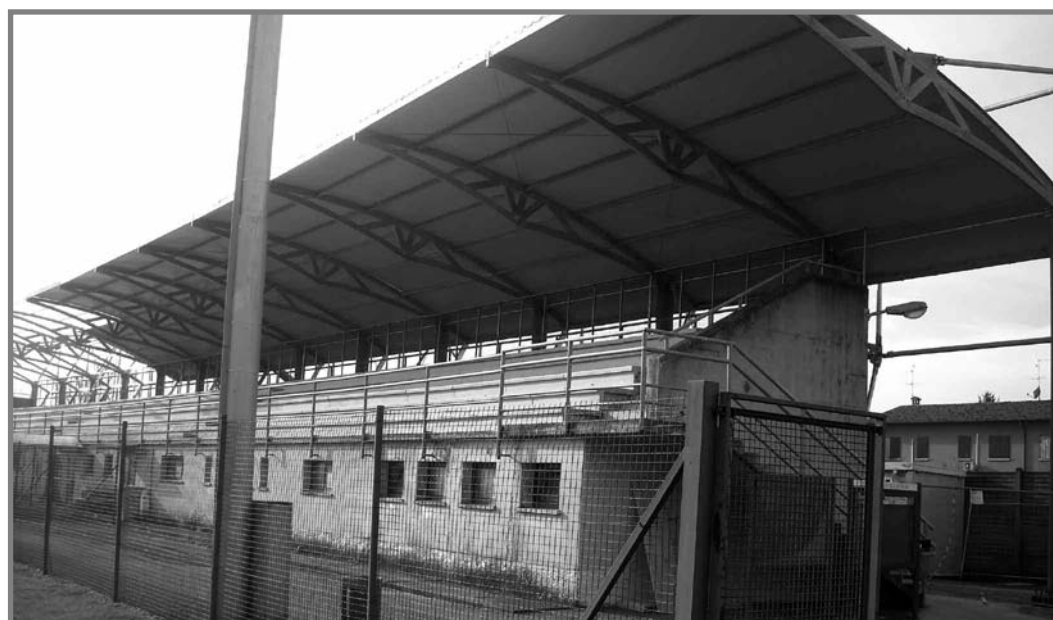
LA COPERTURA DELLO STADIO
